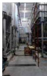
2014 realizzazione 2 nuovi chiarificatori-
