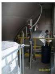
ITR: stazione di ricevimento: tamburo drenante e cono dissabbiatore
