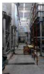
2014 realizzazione 2 nuovi chiarificatori-
