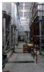
2014 realizzazione 2 nuovi chiarificatori-
