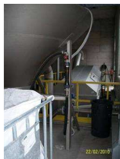
ITR: stazione di ricezione: tamburo drenante, cono dissabbiatore
