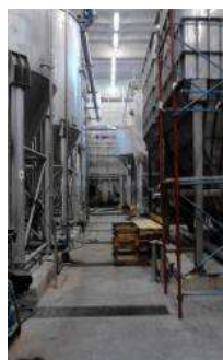
realizzazione 2 nuovi chiarificatori-
